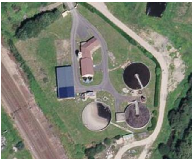
Photo : Station d'épuration de La Souterraine
